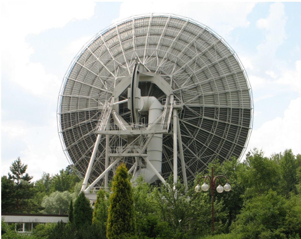
Największa polska antena radiowa (średnica czaszy 32.5 metra) przed pocięciem na złom. Została zniszczona w październiku 2010 roku. (Fot. B. Wszolek)
