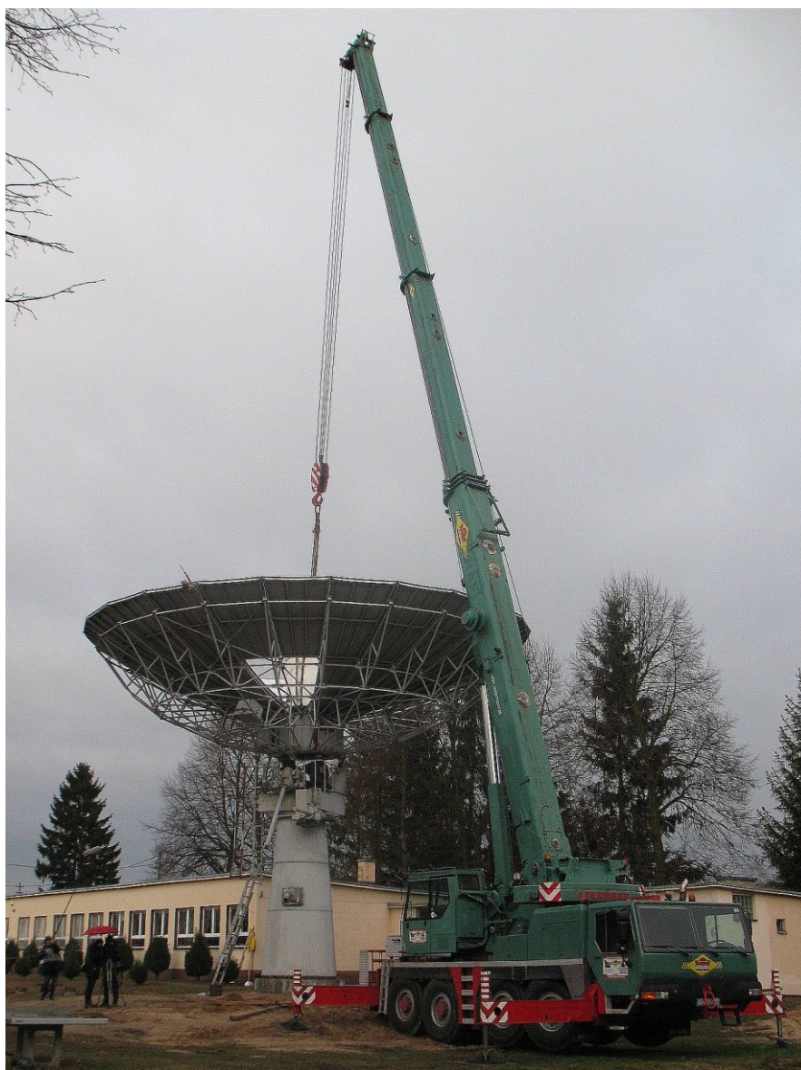
Skomplikowana operacja montażu czaszy RT-13 w Cieszynie.
