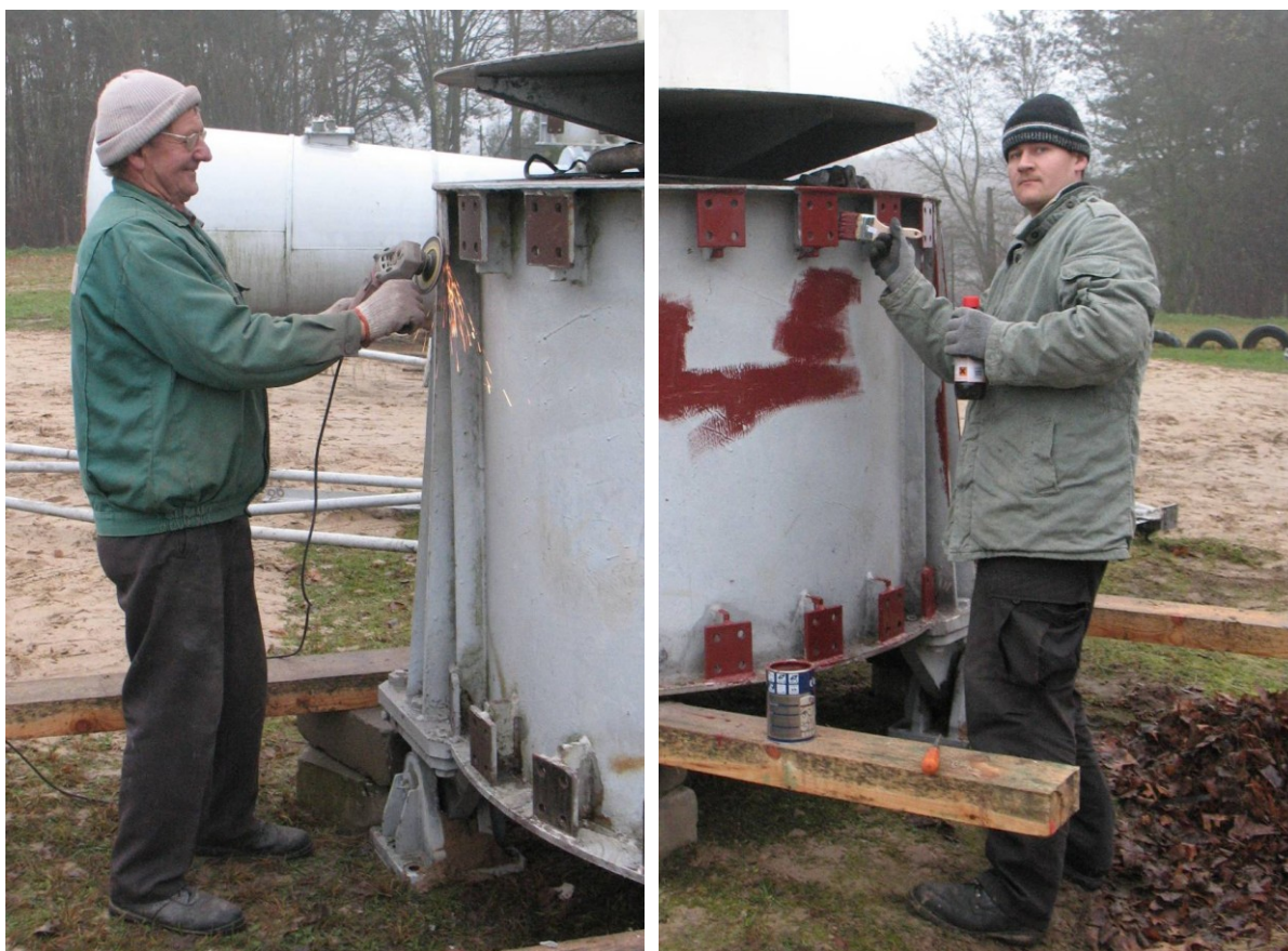
Zabezpieczenia antykorozyjne. W akcji Stanisław Mieszala i Kamil Wszolek.
