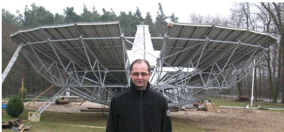
Ojciec Krzysztof Wasiuk, proboszcz parafii Cieszęcin, z wizytą na budowie RT-13.
