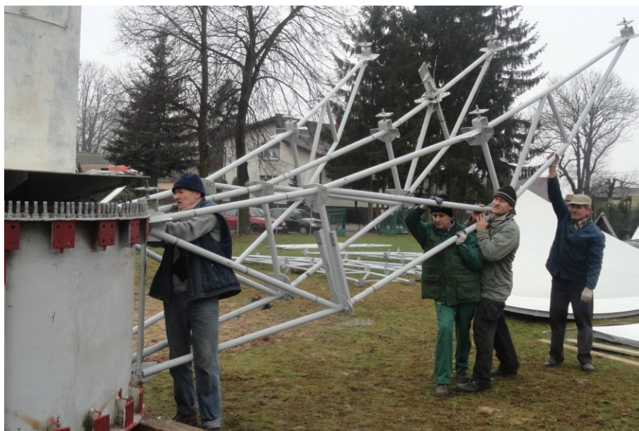
Początek montażu czaszy.
