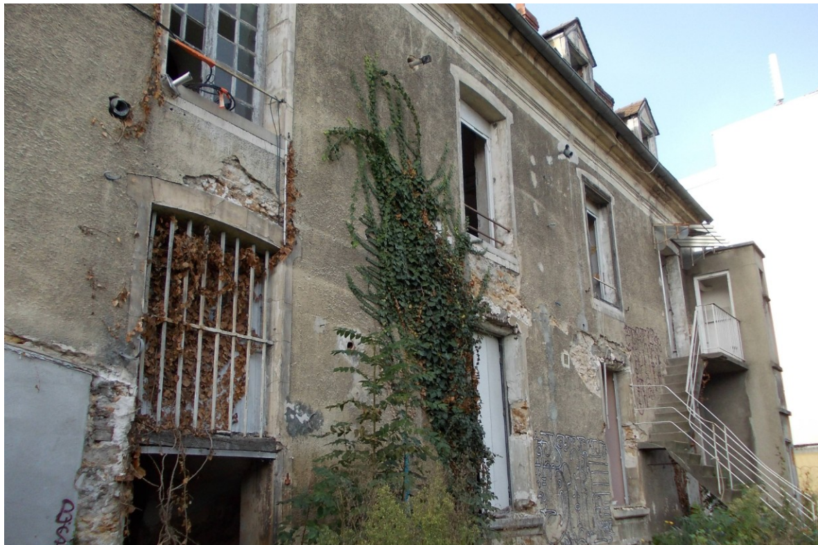
Fasada dawnego domu Szarytek w Juvisy pod Paryżem, w którym żył i pracował ks. Bonawentura Metler. Budynek w stanie ruiny przeznaczono do rozbiórki.
