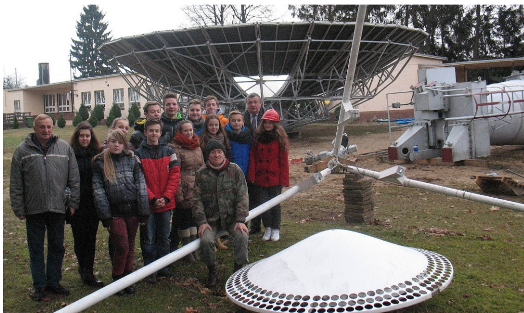
Młodzież z Gimnazjum Jana Pawła II w Wieruszowie pod przewodnictwem dyrektora szkoły mgr. Pawła Malika z wizytą na placu budowy RT-13.
