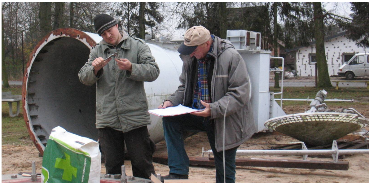
Kamil Wszolek i Kazimierz Błaszczak planują szczegółowo zakup brakujących drobnych elementów potrzebnych do montażu.
