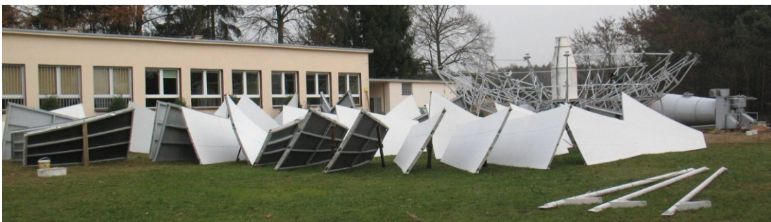
Plac budowy przed montażem paneli. Leżą one umyte i suche w oczekiwaniu powrotu na czaszę.
