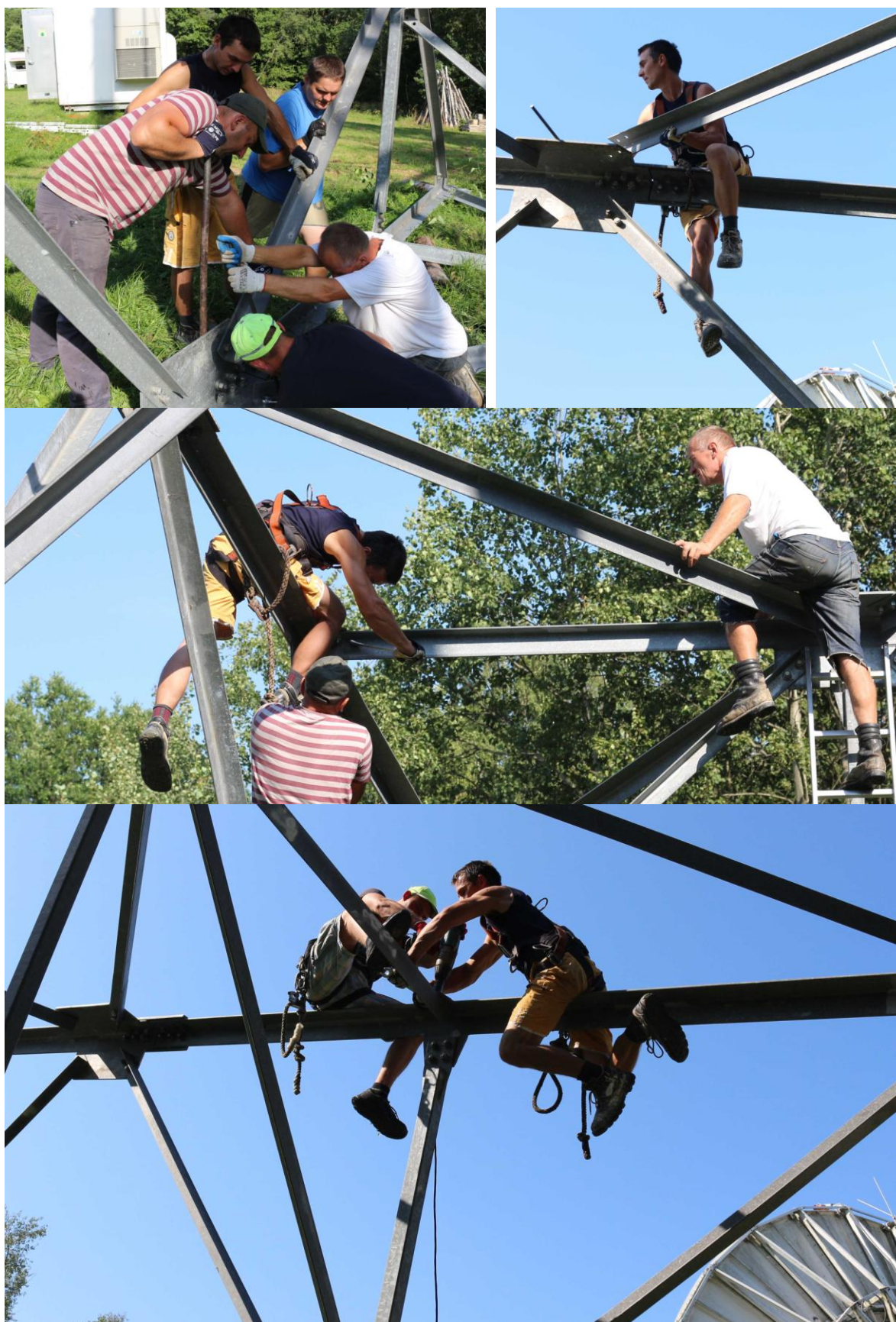
Prace montażowe wieży. Najpierw przy ziemi, potem na wysokościach.
