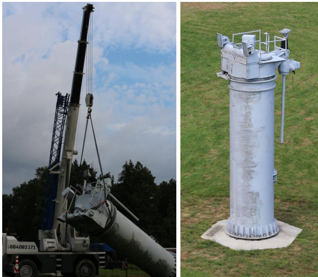
Montaż 11-tonowej nogi radioteleskopu na fundamencie o masie 140 ton.
