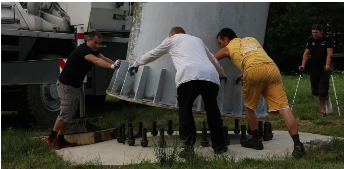
Naprowadzanie 11-tonowej podstawy radioteleskopu na wystające z fundamentu śruby. (OAKJ w Rzepienniku Biskupim, 5 sierpnia 2017)
