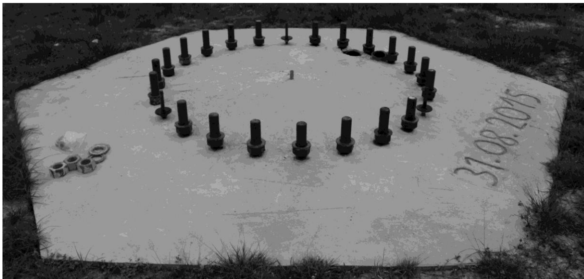
Fundament z wbetonowanymi śrubami pod nogę od RT-16 z Psar.
