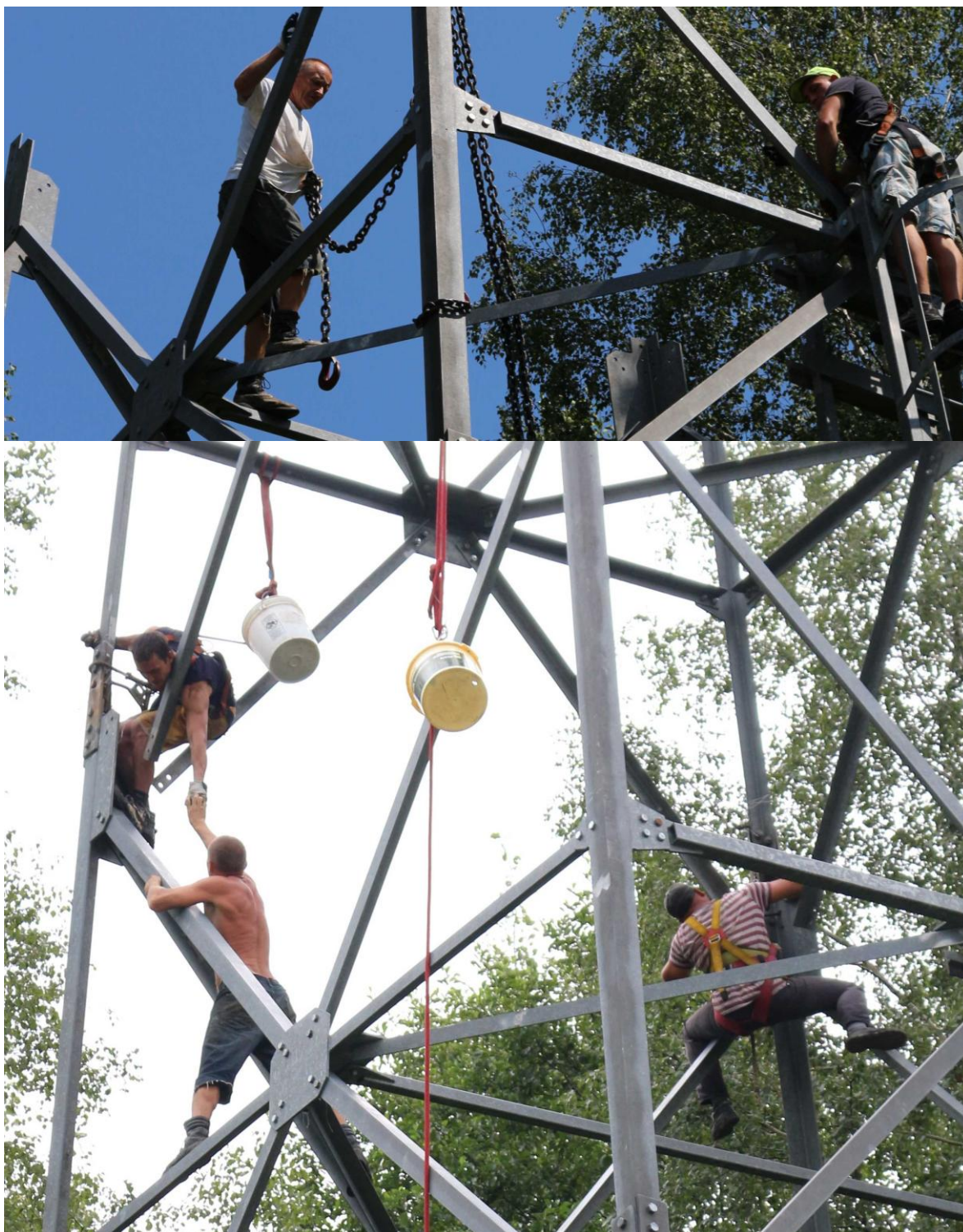
Łączenie trzeciego segmentu z czwartym. Praca na wysokości 15 metrów.
