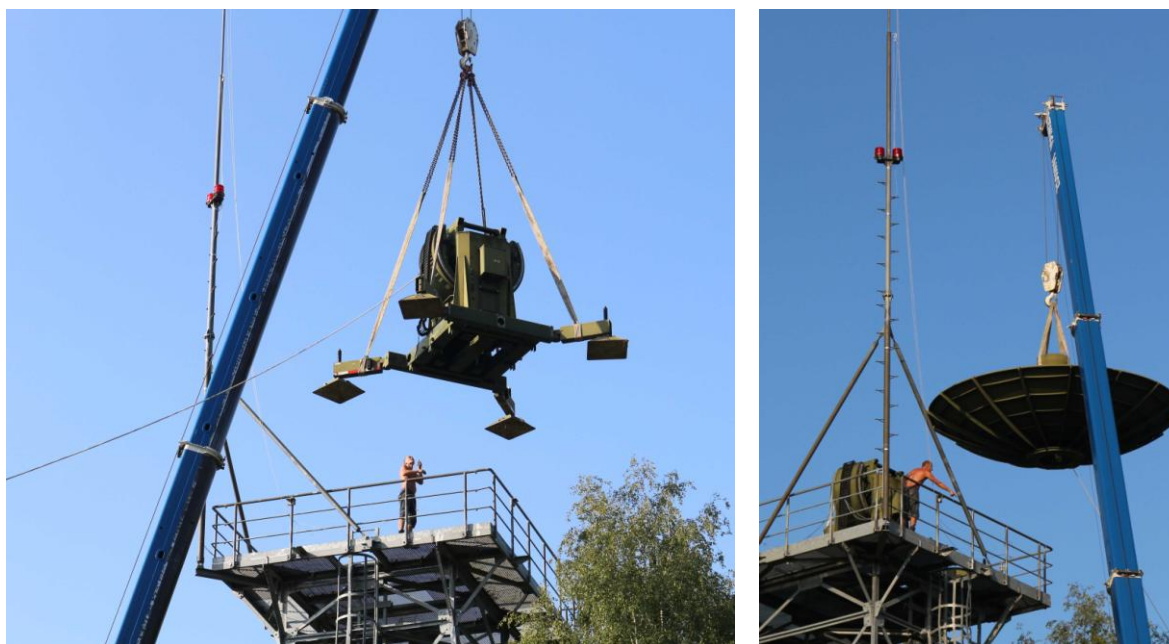
Posadowienie radioteleskopu na platformie i montaż.
