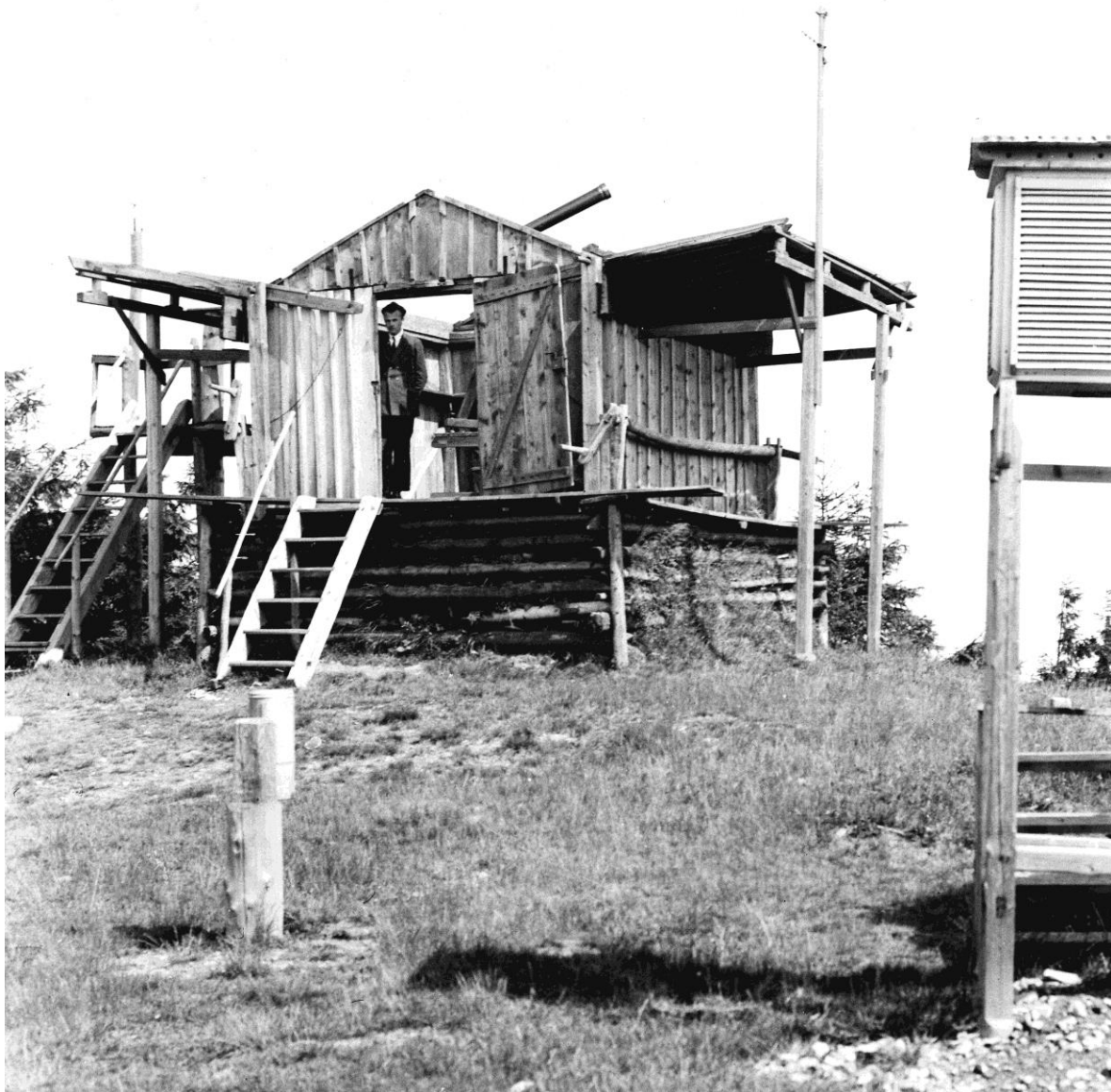
Pierwszy pawilon obserwacyjny na Lubomirze z otwartym dachem.
