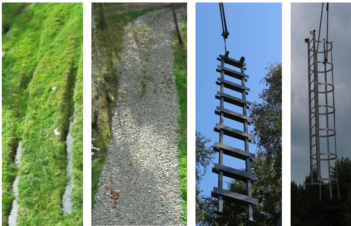
Kolejny po próbie dojazdu dźwigu, zbudowana droga ku wieży i „schody do nieba”.
